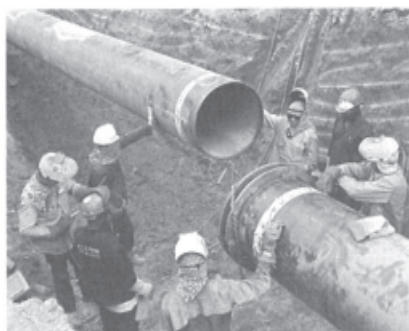
Construcción del oleoducto Chad-Camerún.
