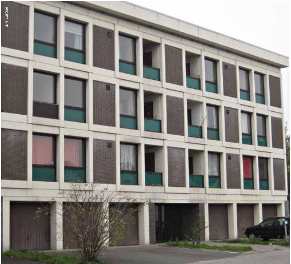
Edificio utilizado para alojar a familias en apartamentos privados, además de oficina de un trabajador social. Tubize, Bélgica.
