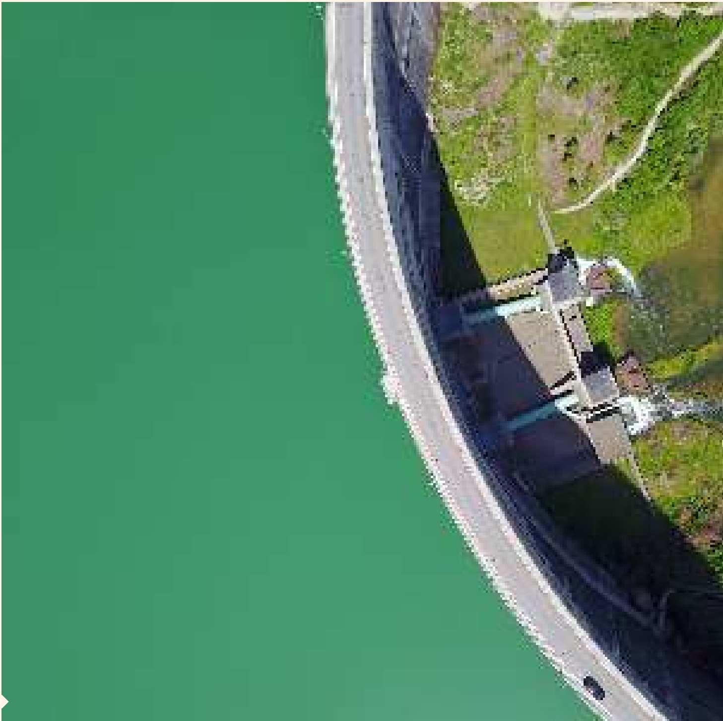
— Presa de Rossens en Suiza
