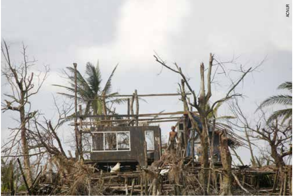
Las ruinas de una casa destruida por el ciclón Nargis, Myanmar. Mayo de 2008.
