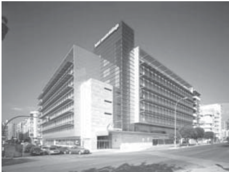
Figura 2. Instalación fotovoltaica en un hotel en Málaga.
