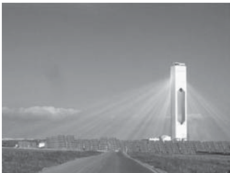
Figura 4. La planta PS10, recién terminada por Solucar, en Sanlúcar la Mayor (Sevilla)
