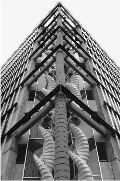
Aerogeneradores en un aparcamiento de Chicago generan la electricidad necesaria para la iluminación exterior del edificio.
